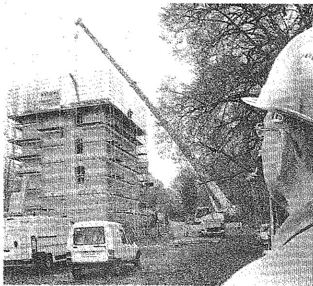
Délicate manœuvre pour hisser et poser la charpente.
